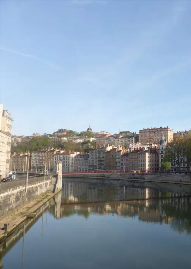
Photographie des entités urbaines cohérentes : " La Saone et le Rhône" Archipat.
