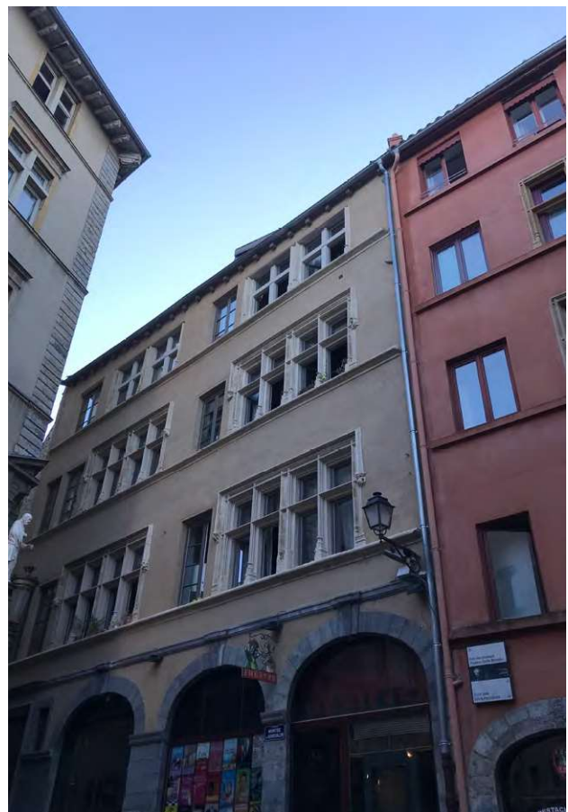
Exemple de façades restaurées, 2 montée du Gourguillon. Archipat
