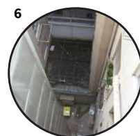
6 Cour exigue, minérale et encombrée par l'ascenseur
