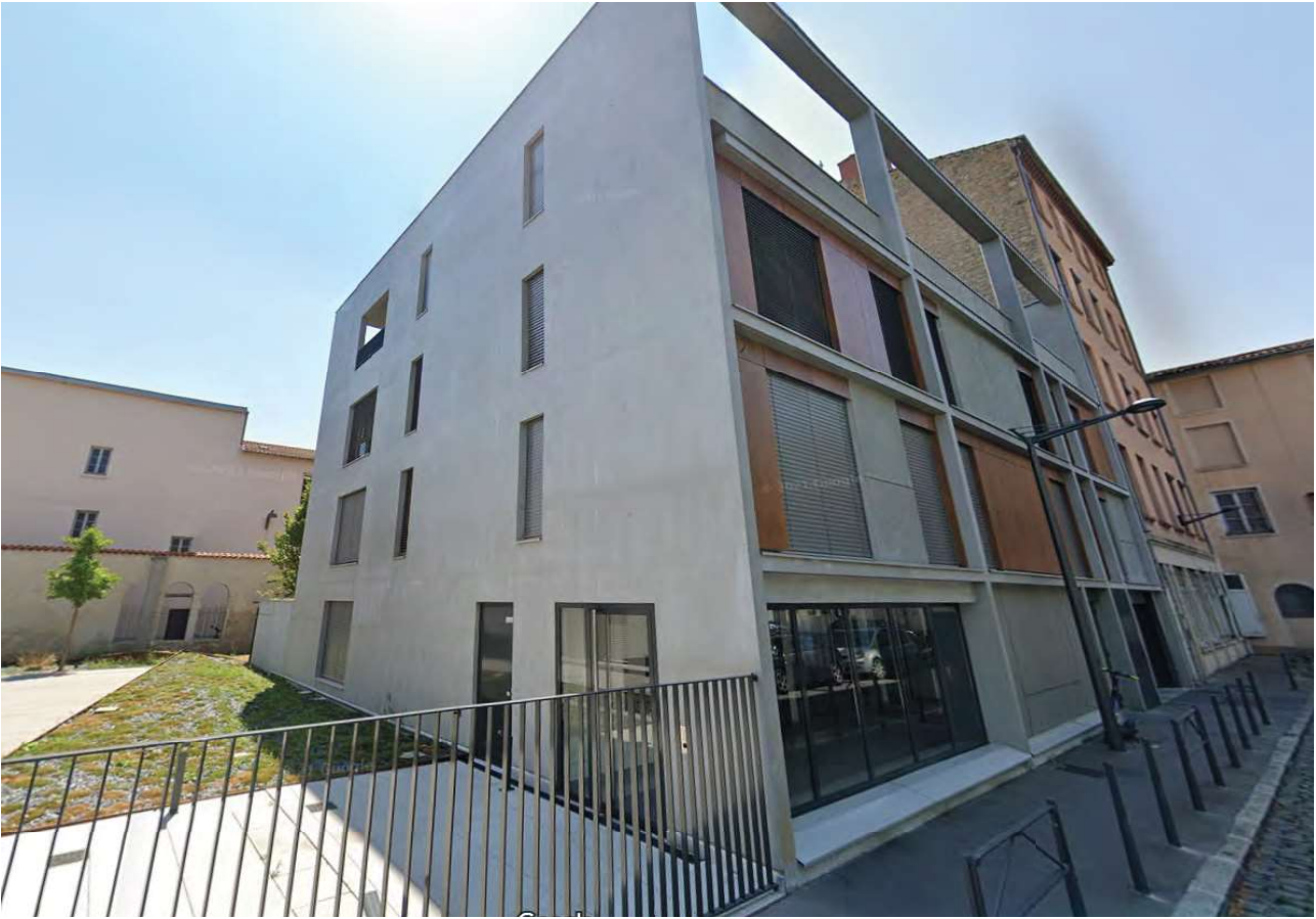
30 place des Chartreux, démolitions ciblées, réhabilitations Google Maps
