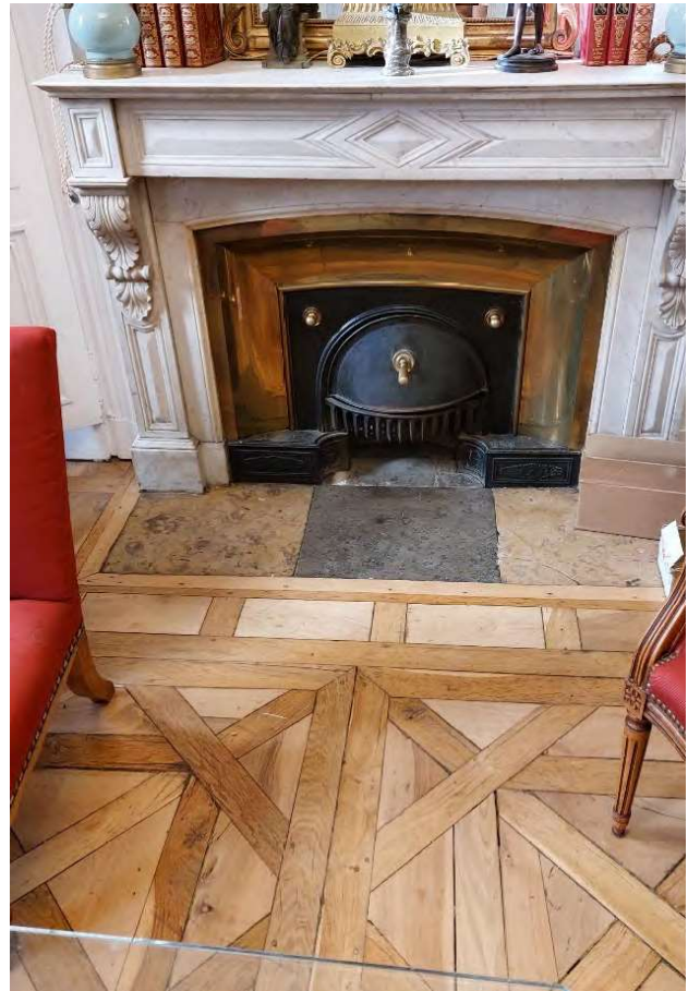
Cheminée et parquets d'Arenberg, 12 rue d'Algérie Ville de Lyon
