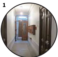
1 Porte d'entrée avec imposte vitrée
